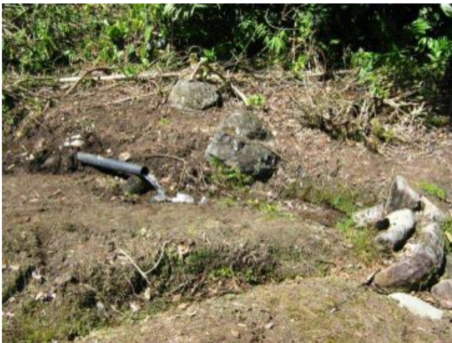
Foto 6. Encauzamiento temporal con tubo PVC de 6" en el sitio de aforo No. 5, en el pie de monte al oeste del estanque de sedimentación (estructura 14d). (Op. 33b).
