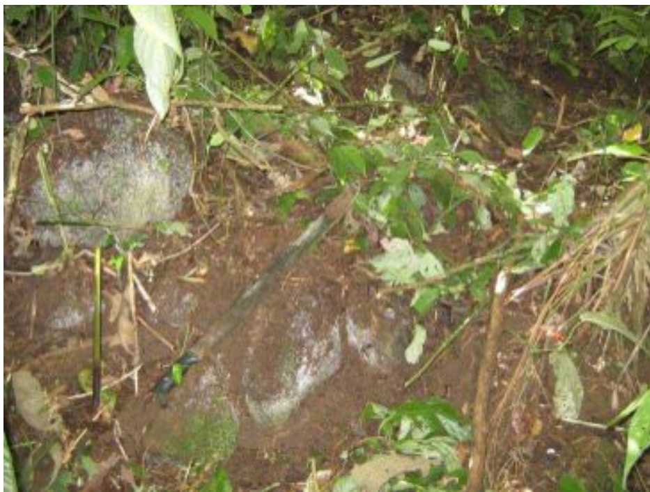
Foto 3. Sección de muro con tres hiladas de roca en la parte media de la ladera, que tiene continuidad por más de 10m de longitud. Se localiza a unos 10m al norte del sendero de visita y 12m hacia el oeste del canal de desagüe marcado en los Planos 1 y 2. (Op. 33a).
